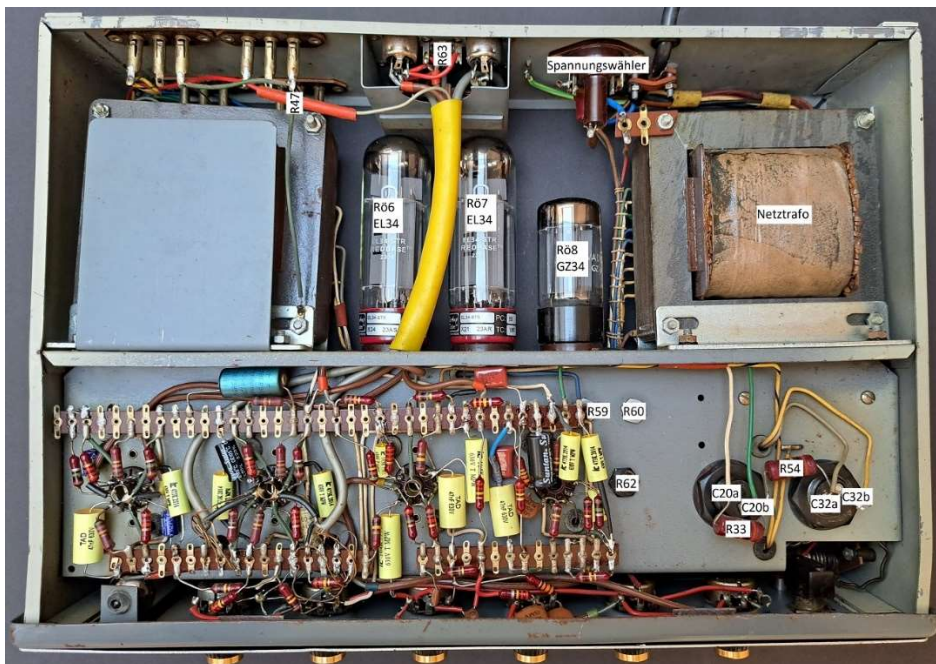
Ansicht des restaurierten Verstärkers von unten mit Bauteilnummern
